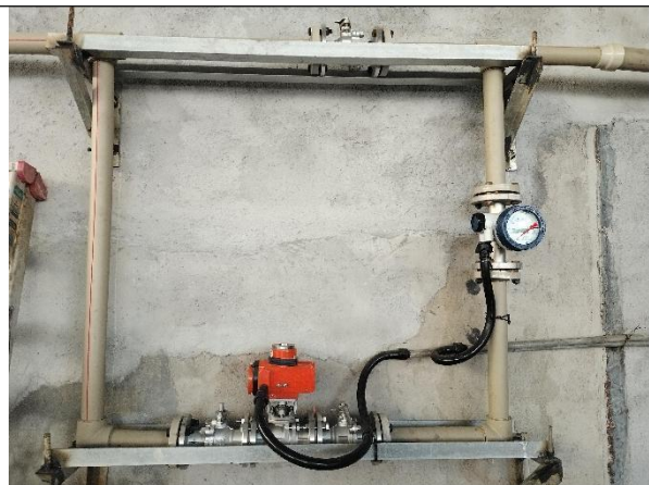
照片 5 氯酸钠溶液总管切断阀和流量计
