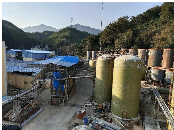
照片 15 原有的盐水罐区
