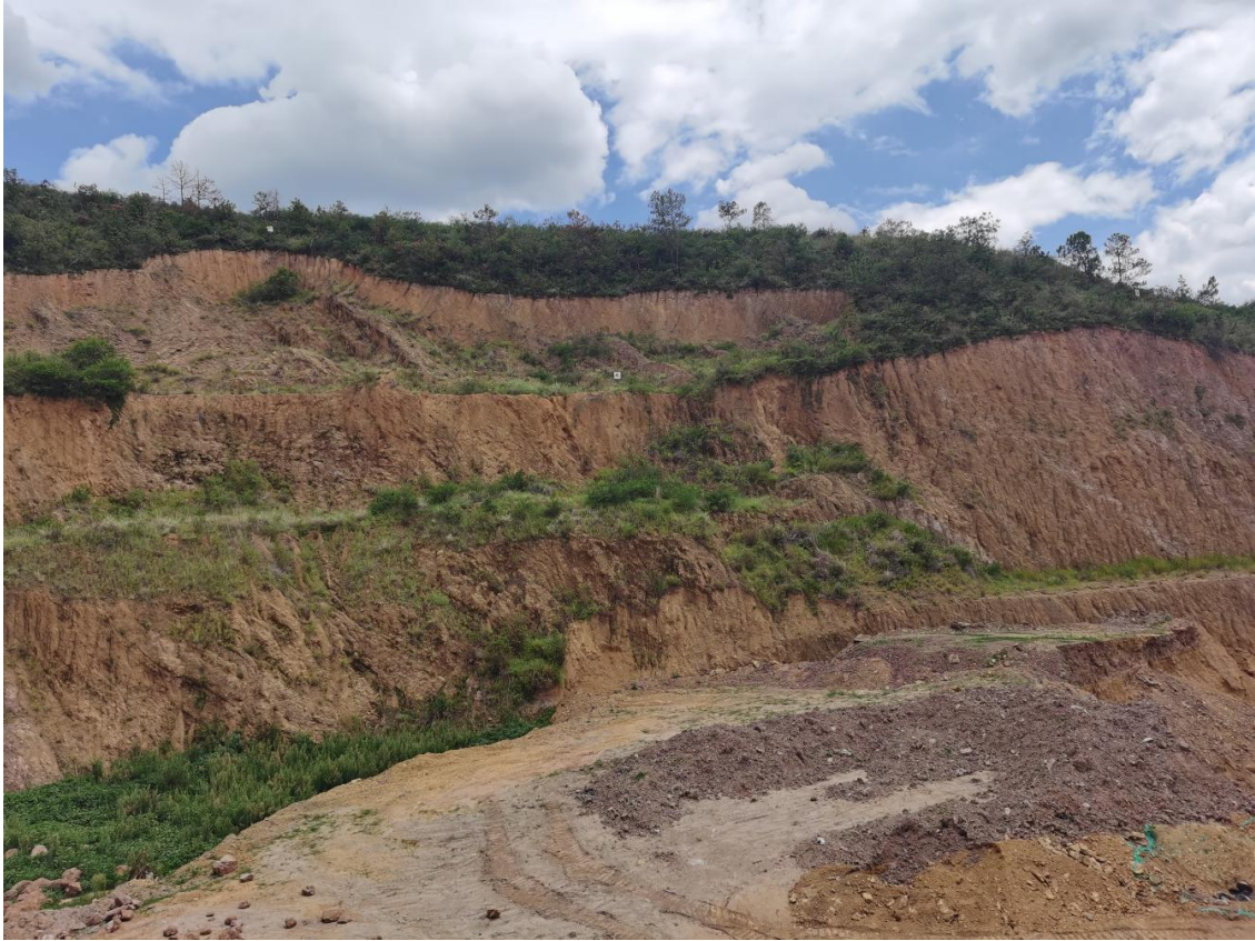
采场现状航拍图：
