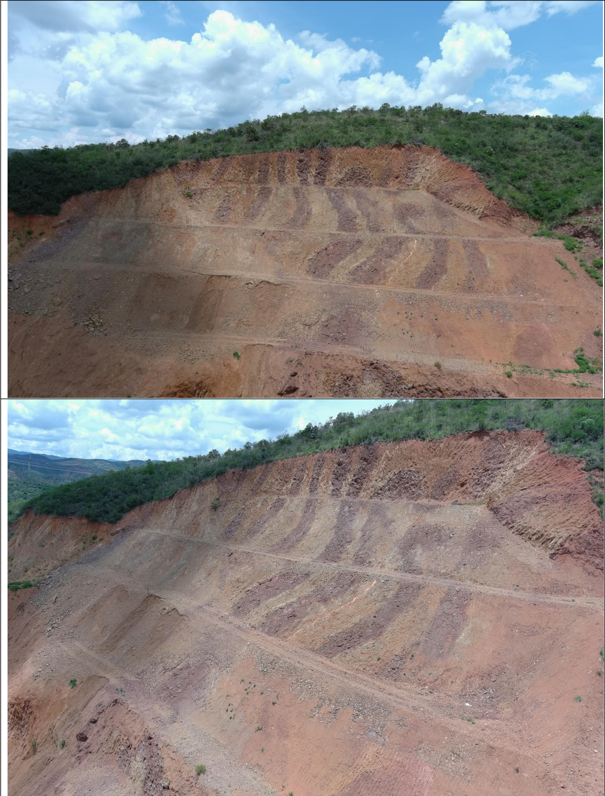
图 2—4 采场南侧现状图（2020 年底已形成终了边坡）
